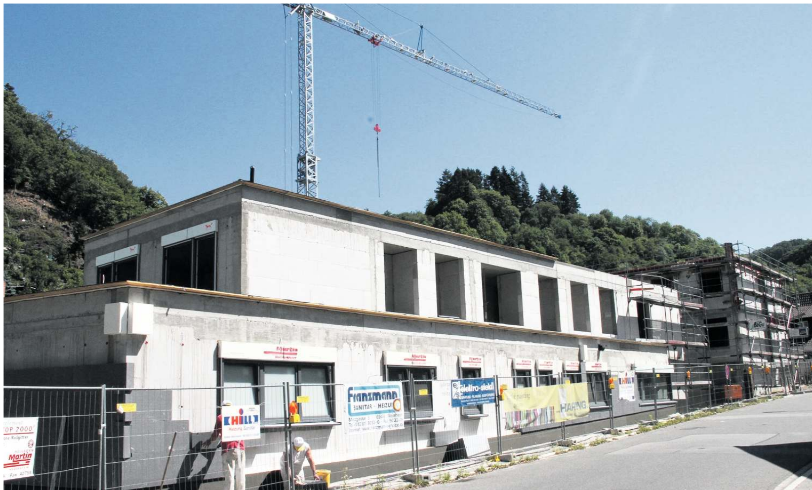
Der Rohbau steht: Bis Ende des Jahres will die Arbeiterwohlfahrt Rhein-Neckar in der Weinheimer Burggasse ihr Haus „AWO Soziale Dienste“ eröffnen. Gestern wurde Richtfest gefeiert. Rund 4,5 Millionen Euro kostet der Neubau.
